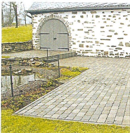
5. Farbschwankungen aufgrund der Lieferung aus unterschiedlichen Lieferwerken.
