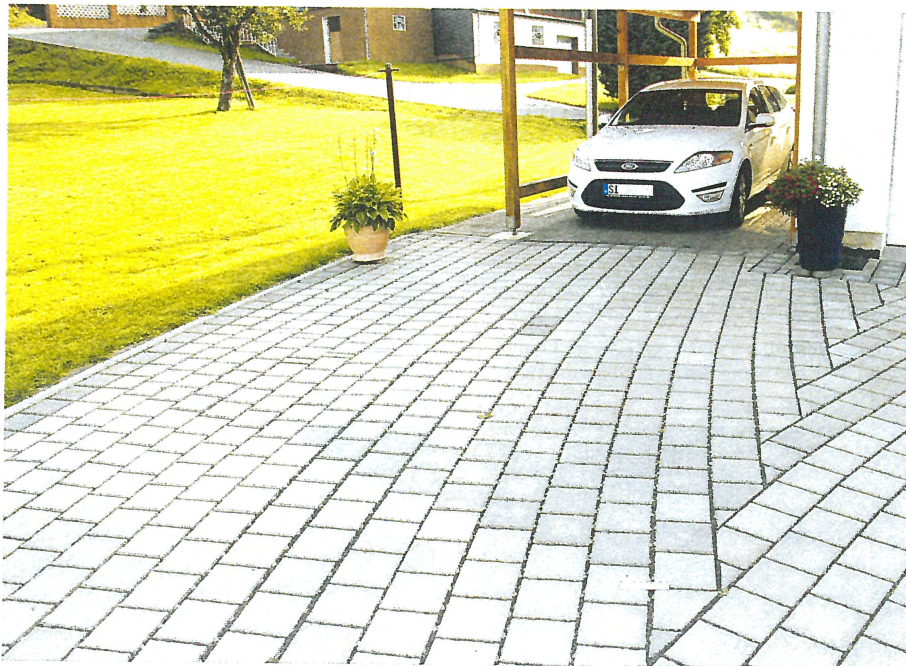
13. Palettenweise Verlegung von Betonpflastersteinen.
