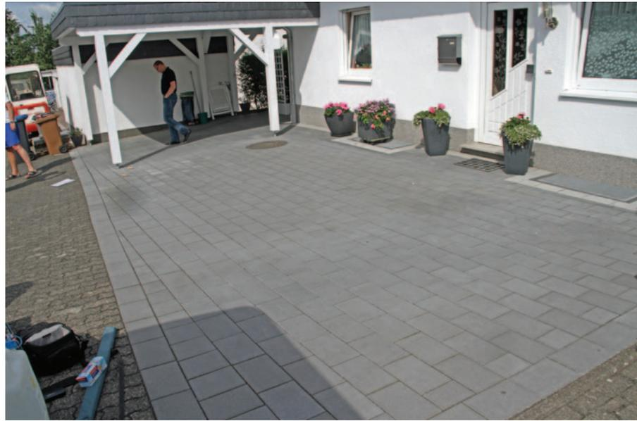
Abb. 2: Gering beanspruchte aber befahrene Pflasterdecken
