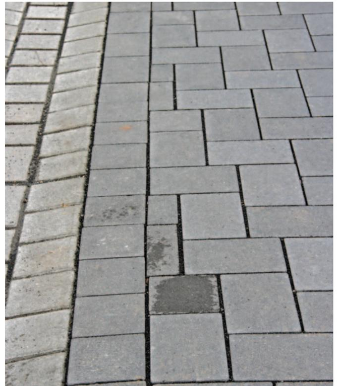
Abb. 1: Aufgrund der Fugenbreite reklamierte Pflasterdecke
