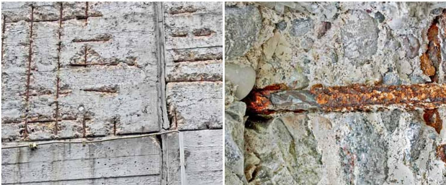
Abb. 1/2: Durch korrodierten Bewehrungsstahl kommt es zu einer Volumenvergrößerung und damit zu Betonabplatzungen oberhalb des Bewehrungsstahls.
