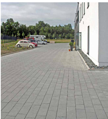
Abb. 1: Verfärbung von anthrazitfarbenen Pflastersteinen aus Beton durch das verwendete Fugenmaterial
